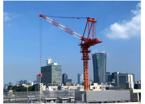
図4: 家の前のタワークレーン
