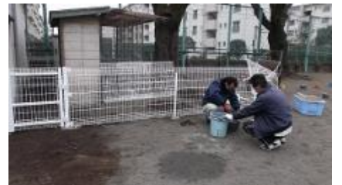
小屋の周辺に柵を設置している様子
