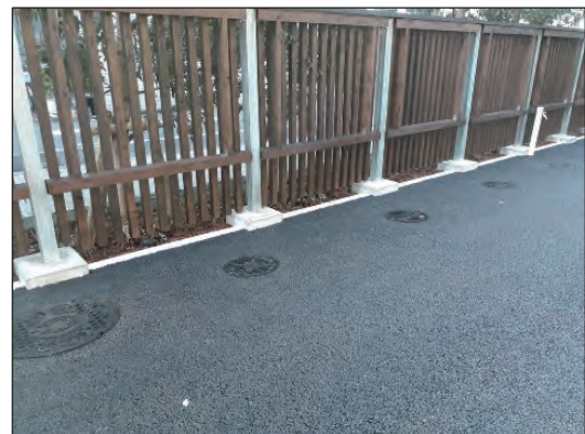
【都立特別支援学校に設置されているマンホールトイレの例】
