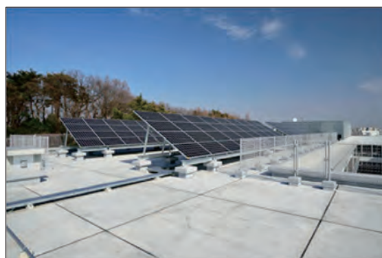
【都立特別支援学校において太陽光発電パネルを設置した例】
