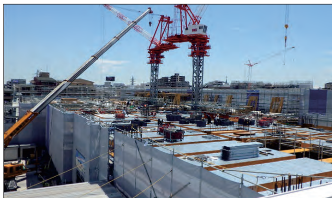
【工事中の都立特別支援学校の例】
