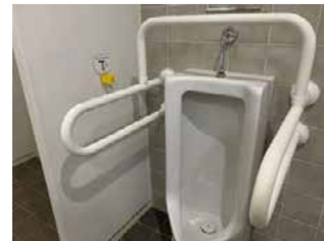
手すりの設置
