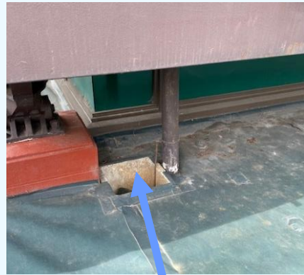
雨水配管が金属製で施設内に埋設している構造
