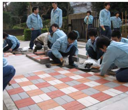
小学校のエントランス工事
