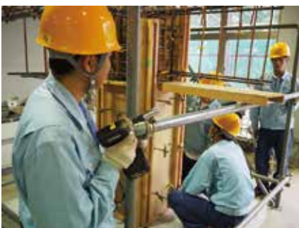
＜コンクリート型枠の製作＞
