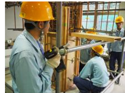
<コンクリート型枠の製作>
