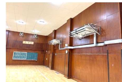
都立高校武道場の空調整備
